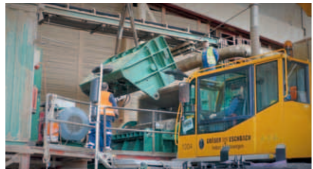
Oben: Modernisierungsmaßnahmen an einer Prallhammermühle
